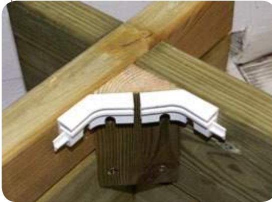
▶ Bringen Sie in jeder Ecke 2 Klemmprofil-Eckstücke an. (Sie finden die Teile im Set Folie/ Abdichtung). Dazu ist es erforderlich, von jedem Eckstück die Verbindungszapfen zu entfernen. Achten Sie darauf, dass sich die beiden Eckstücke auf gleicher Höhe befinden und bündig mit der Beckenoberkante abschließen. Zwischen den beiden Eckstücken darf durchaus ein kleiner Spalt von wenigen mm bleiben. Verwenden Sie die Edelstahlschrauben 4x35 aus Beutel H.
