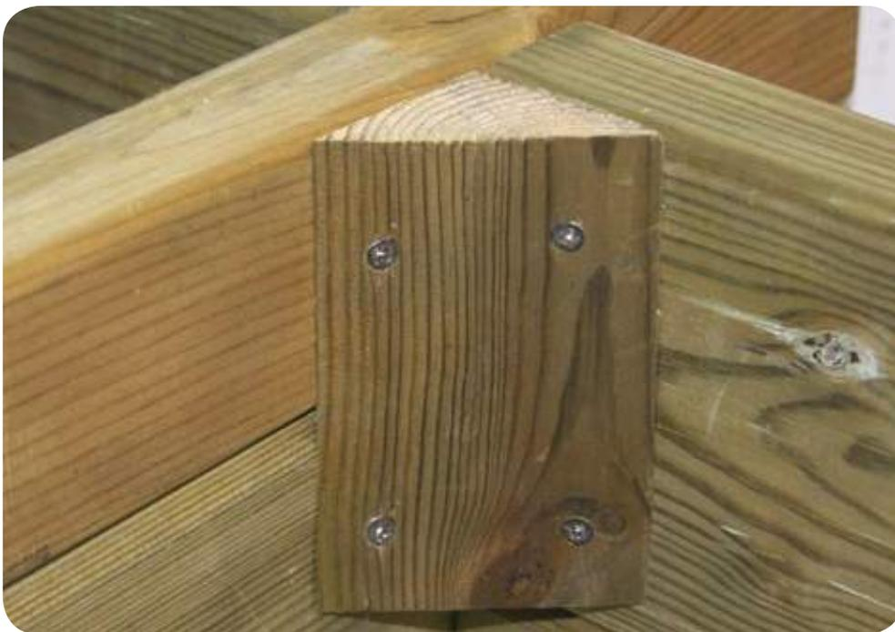
► Montieren Sie in jeder Ecke einen dreieckigen Holzkeil für die spätere Befestigung der Klemmprofil-Eckstücke (Edelstahlschraube 5x40, Beutel C).
