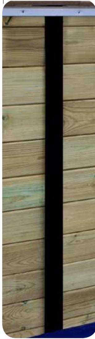
► Decken Sie die vertikalen Fugen mit einem Stück Klebeband ab (Klebeband im Set Folie/ Abdichtung enthalten); achten Sie dabei besonders darauf, dass die Schraubköpfe abgedeckt sind.
